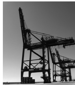
Rys. 5. Nabrzeżny żuraw portowy Fig. 5. Quay Crane
