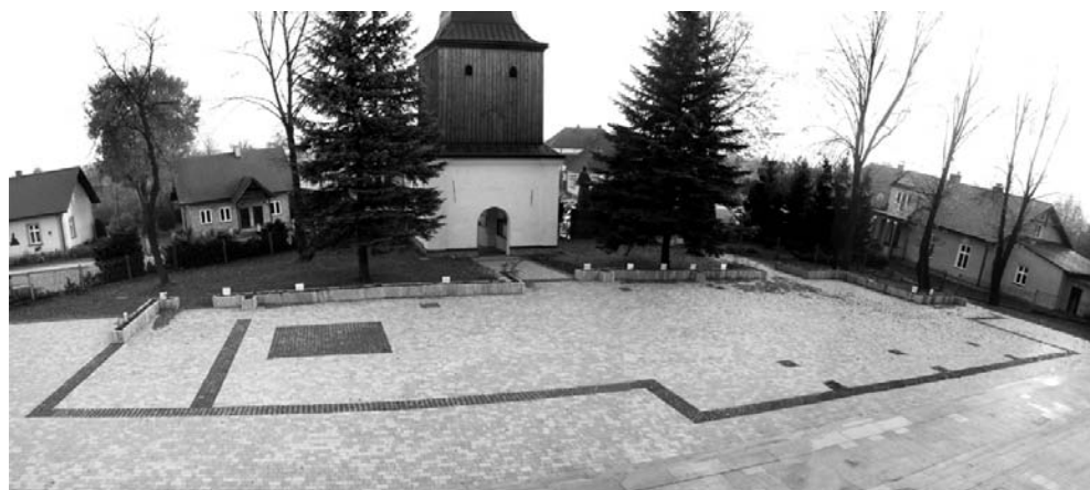
II. 2. Panoramiczne zdjęcie realizacji placu przed kościołem – pierwszego etapu projektu ogrodu pamięci w Niegowici (fot. Łukasz Dąbrowski). Źródło: archiwum autorów
