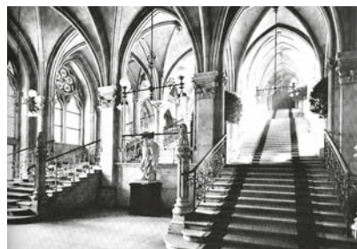
Ryc. 14. Klatka schodowa Nowego Ratusza, Wiedeń. G.F. von Schmidt, 1872-1883 Fig. 14. New Town Hall, the staircase. Vienna. G.F. von Schmidt, 1872-1883
