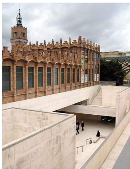
Ryc. 10. Caixa Forum – widok na zagłębiony dziedziniec wejściowy od południowego zachodu, fot. autor Fig. 10. Caixa Forum – view of the sunken entrance courtyard from the south-west – photo by author
