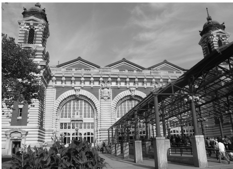
Il. 5. Budynek główny, fasada zachodnia od strony portu. Wejście główne, zadaszony portyk dobudowany w ramach rewitalizacji (fot. autor, 2009)
