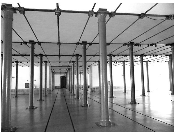
Fot. 20. Budynek Alfandega Nova. Fragment przestrzeni wielofunkcyjnej na parterze obiektu, fot. D. Kuśnierz-Krupa, 09.2012 Photo 20. The building of Alfandega Nova. Fragment of multi-functional space on the ground floor, photo by D. Kuśnierz-Krupa, 09.2012
