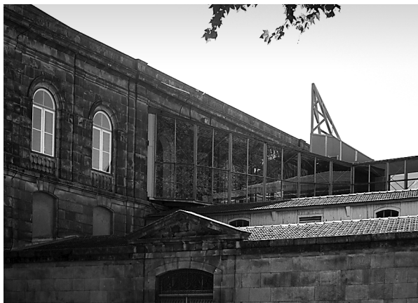
Fot. 4. Widok na fragment elewacji Alfandega Nova, gdzie zastosowano współczesne detale architektoniczne, fot. D. Kuśnierz-Krupa, 09.2012 Photo 4. View of the elevation fragment of Alfandega Nova, where modern architectural details were used, photo by D. Kuśnierz-Krupa, 09.2012
