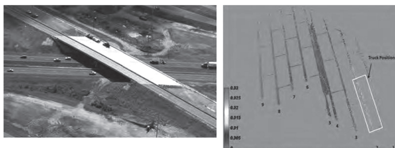
Rys. 2. Odkształcenia elementów mostu obciążonego ciężkimi pojazdami [6]
