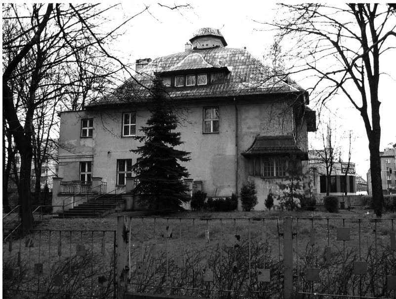
II. 2. Chorzów, willa dyrektorska przy ul. Dąbrowskiego 22 (foto K. Łakomy, 2007)
