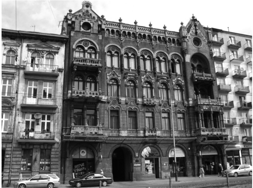
II. 4. Kamienica braci Awerbachów, z 1896 r. wg projektu Gustawa Landau-Gutentegera wymaga remontu – ul. Narutowicza 32 (fot. B. Wycichowska, 2011)
