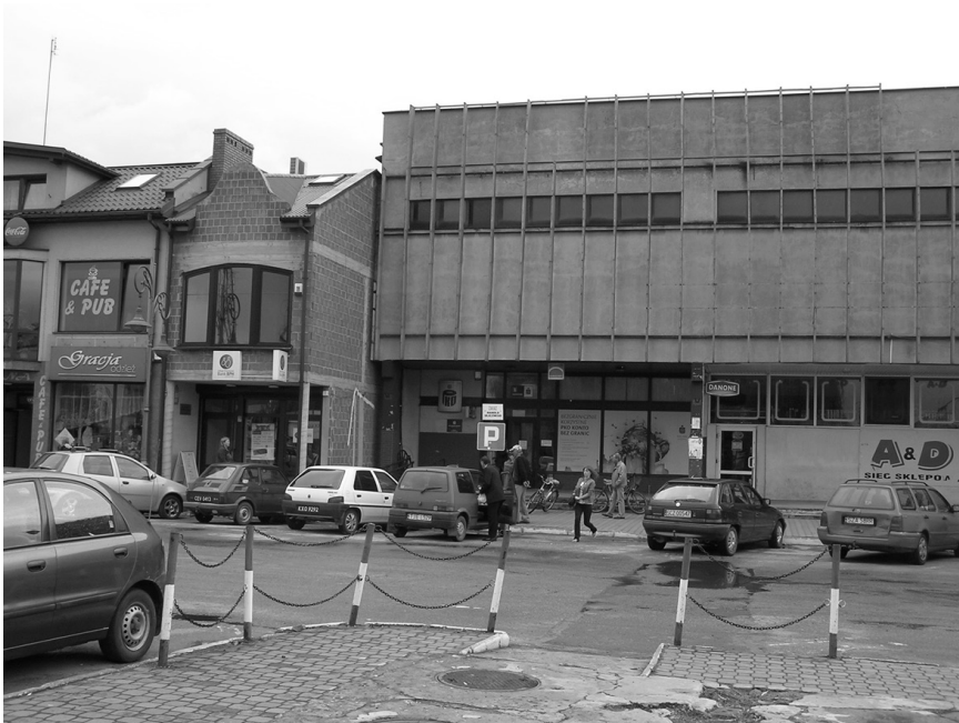
II. 3. Przykład uzupełnienia zabudowy na rynku w Szczekocinach (fot. K. Mazur-Belzyt)
