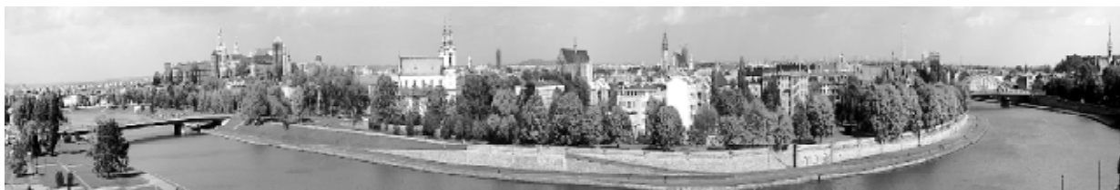
Ryc. 2. Współczesny widok na zabudowę zakoli Wisły Wawel – Skalka – Kazimierz Fig. 2. Present-day view of the building development in the Vistula bends: Wawel – Skalka – Kazimierz
