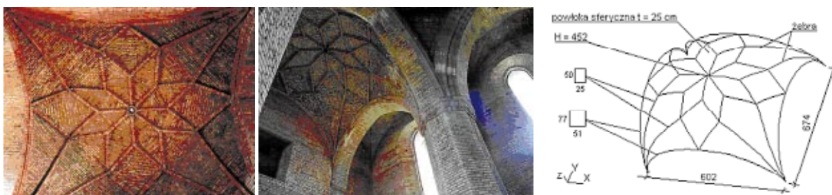
Ryc. 4. Widok wykonanego sklepienia i układ elementów nośnych oraz model 3D konstrukcji powłoki Fig. 4. View of the executed vault and the arrangement of load-bearing elements, and a 3D model of the shell construction
