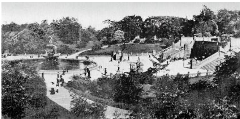
Ryc. 5. Bethesda Terrace – zdjęcie z ok. 1900 roku Fig. 5. Bethesda Terrace – Fig. from about 1900
