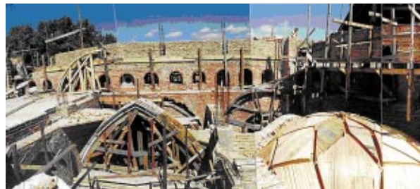
Ryc. 8. Fragment konstrukcji sklepień i łuków Fig. 8. Fragment of vault and arch construction
