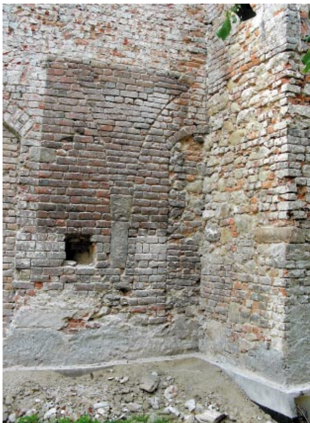
Ryc. 3. Wodzisław Śląski, kościół pofranciszkański, ściana południowa prezbiterium, przęsło zachodnie. Ceglane lico wnętrza oratorium w wątku mieszanym, miejscami wendyjskim, miejscami gotyckim-polskim. Pośrodku ciosy skutego wspornika sklepienia, a ponad nimi zamurówka wozówkowa i główkowa, licująca odsadzki przyścienne sklepień. Po bokach wnęki arkadowych przejść. Po prawej wtórnie dobudowana przypora prezbiterium (fot. J. Węćławowicz, 2008)
