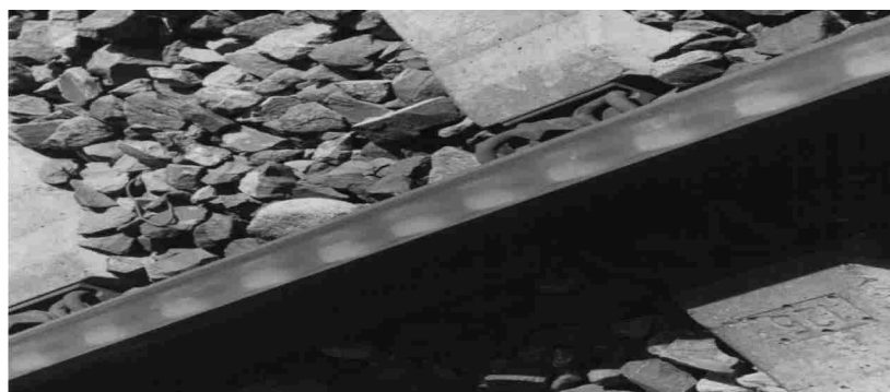
Rys. 6. Fale poślizgowe na torach z łukami (długość fali około 120 mm, amplituda przekraczająca 300 \mu\text{m} )
