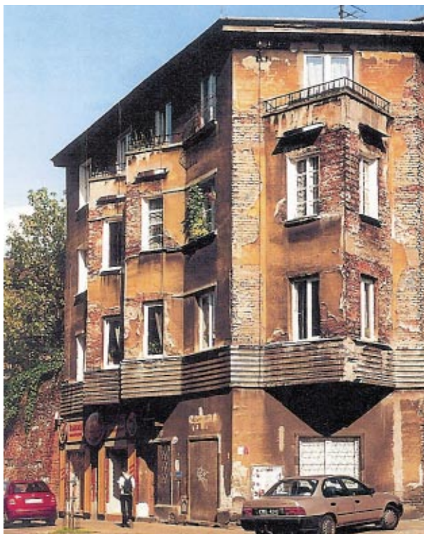
Ryc. 1. Kraków, budynek mieszkalno-usługowy przy ul. Miodowej 39. J. Krylowski, 1929 Fig. 1. A residential and service building at 39 Miodowa Street. Kraków. J. Krylowski, 1929
