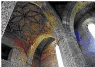
Ryc. 4. Widok wykonanego sklepienia i układ elementów nośnych oraz model 3D konstrukcji powłoki Fig. 4. View of the executed vault and the arrangement of load-bearing elements, and a 3D model of the shell construction
