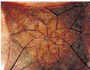
Ryc. 4. Widok wykonanego sklepienia i układ elementów nośnych oraz model 3D konstrukcji powłoki Fig. 4. View of the executed vault and the arrangement of load-bearing elements, and a 3D model of the shell construction
