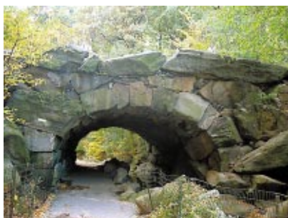
Ryc. 19. Huddleston Arch Fig. 19. Huddleston Arch
