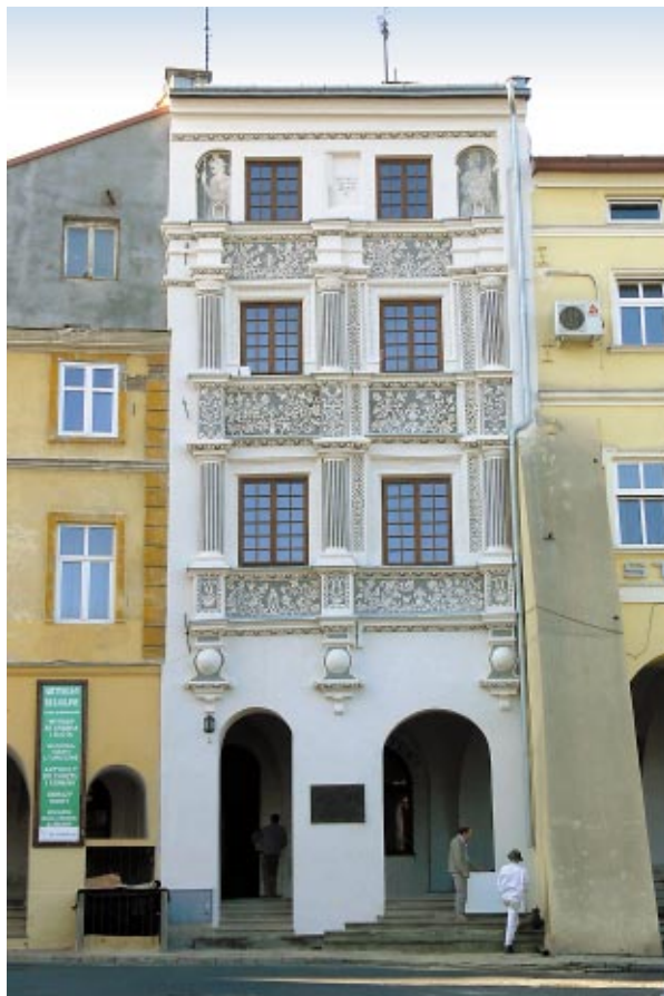
Ryc. 2. Fasada kamienicy Rynek 15 po konserwacji w 2009 roku Fig. 2. Façade of the tenement house at 15 Market Square after conservation in 2009
