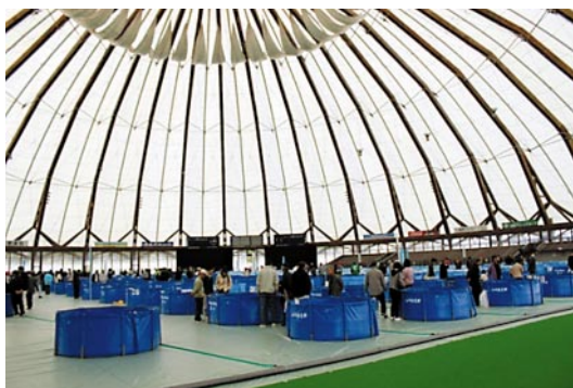
Ryc. 15. Widok kopuły Izumo Dome [9] Fig. 15. View of Izumo Dome [9]
