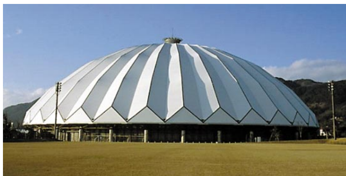
Ryc. 14. Widok zewnętrznego pierścienia składającego się z trójkątnych elementów [4] Fig. 14. View of outer ring consisting of triangular elements [4]
