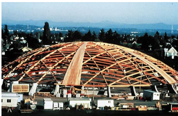
Ryc. 13. Widok konstrukcji dwudziestościanu foremnego Tacoma Dome [4] Fig. 13. View of Tacoma Dome's regular icosahedron [4]
