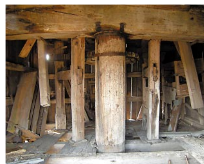
Ryc. 6. Bierzglów, wiatrak koźlak z 1867 r. Widok na pierwszą kondygnację ze sztembrem i mącznicą (fot. M. Prarat, 2010)
