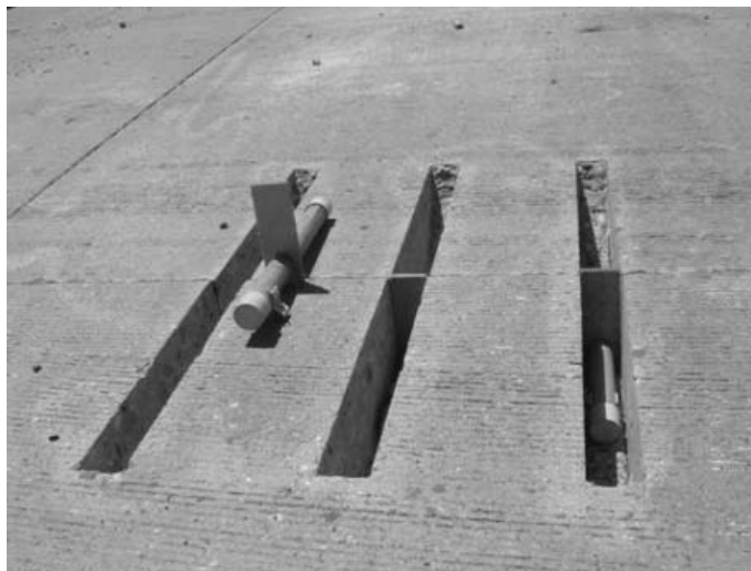
Rys. 4. Wycięte w nawierzchni szczeliny przeznaczone do montażu dybli [5]
