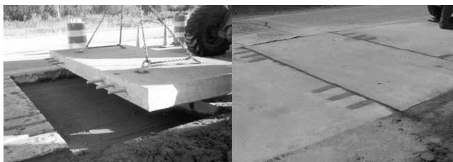
Rys. 6. Instalacja oraz efekt końcowy naprawy z zastosowaniem płyty prefabrykowanej [4]
