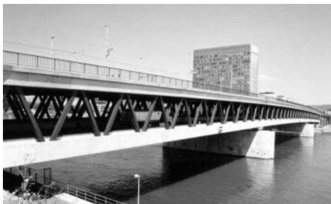
Rys. 3. Konstrukcja podwójnie zespolona – most „Dreirosen”
