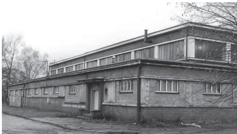
Il. 4. PKWK Jawiszowice. Budynek cechowni i szatni. Widoczne przekształcenia otworów okiennych (fot. J.K. Lenartowicz, 2009)
