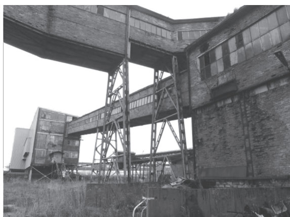
Il. 5. PKWK Jawiszowice. Mosty przeładunkowe, w głębi budynek sortowni i płuczki (fot. J.K. Lenartowicz, 2009)
