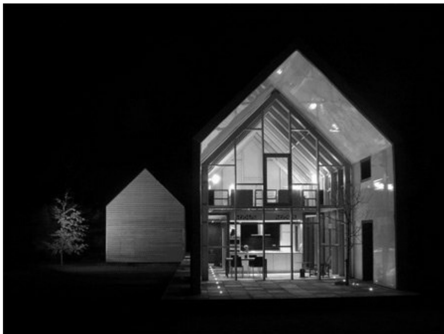
II. 3. Sliding House, hrabstwo Suffolk, Wlk. Brytania, projekt: biuro de Rijke Marsh Morgan (dRMM) (fot. biuro de Rijke Marsh Morgan (dRMM), źródło: http://architektura.muratorplus.pl/technika/budynki )
