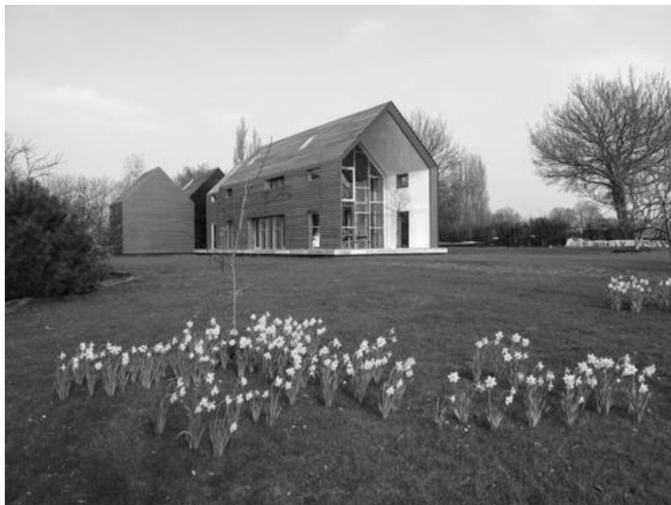
II. 2. Sliding House, hrabstwo Suffolk, Wielka Brytania, projekt: biuro de Rijke Marsh Morgan (dRMM) (fot. biuro de Rijke Marsh Morgan (dRMM), źródło: http://architektura.muratorplus.pl/technika/budynki )
