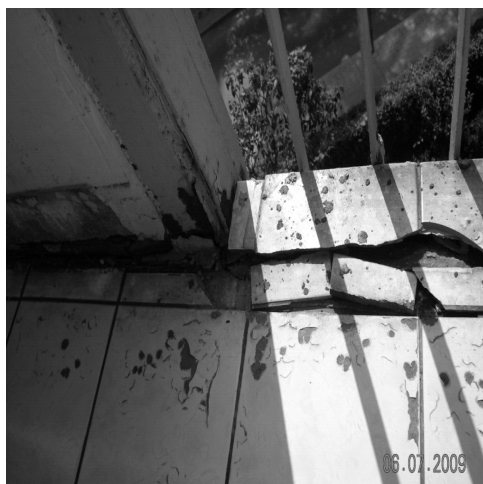
Il. 4. Uszkodzenia żelbetowej płyty balkonowej oraz osłonowej w obszarze mocowania balustrady
