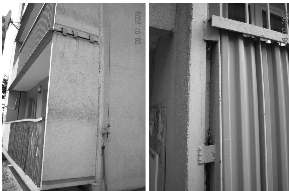
Il. 3. Widok balkonowej płyty osłonowej oraz sposób mocowania balustrady
