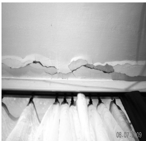
Il. 5. Zarysowania sufitu i posadzki w obszarze monolitycznej belki
