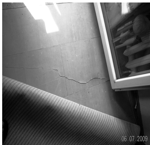
Il. 5. Zarysowania sufitu i posadzki w obszarze monolitycznej belki
