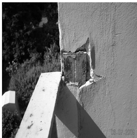
Il. 4. Uszkodzenia żelbetowej płyty balkonowej oraz osłonowej w obszarze mocowania balustrady
