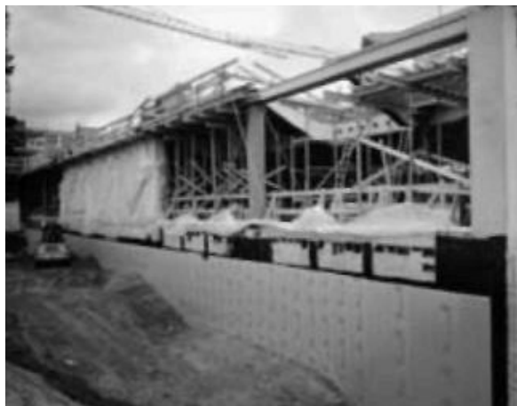
II. 7. Zagęszczanie gruntu wokół ścian fundamentowych.
