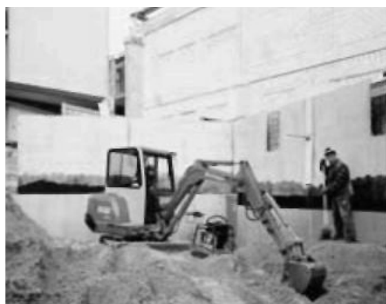
II. 6. Prawdłowo obsypywane ściany piwnic
