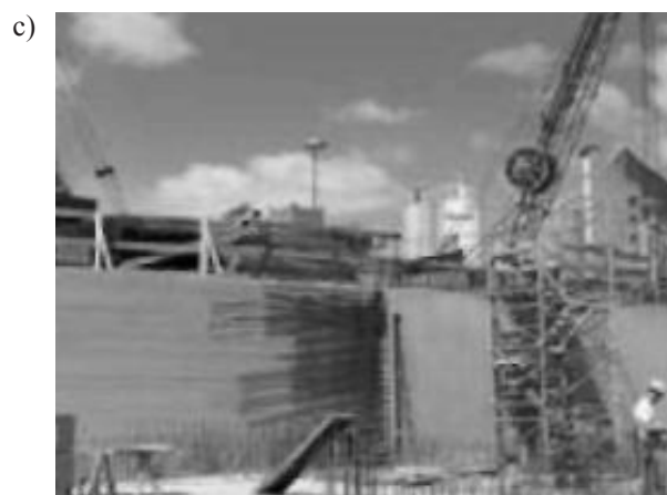
II. 2. Izolacja termiczna: a) fundamentów przestrzennych, b) w strefie cokółu, c) ściany szczelinowej
