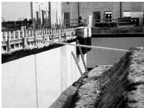
II. 4. Prawidłowo zamontowane płyty XPS i zasypyany kruszywem drenaż
