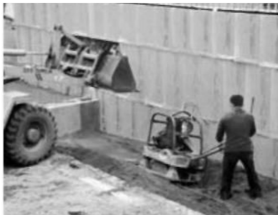
II. 5. Izolacja termiczna ścian piwnic
