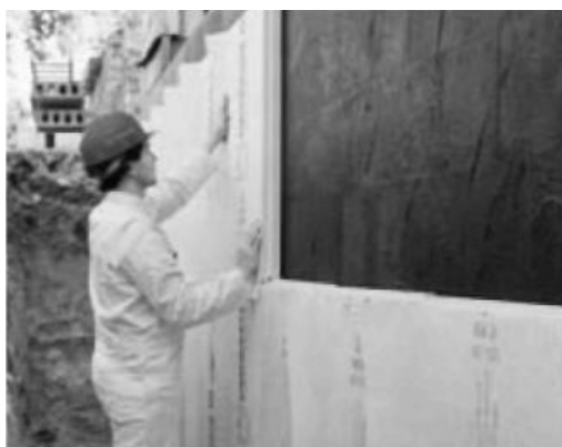
II. 1. Montaż płyt XPS firmy Daw Chemical
