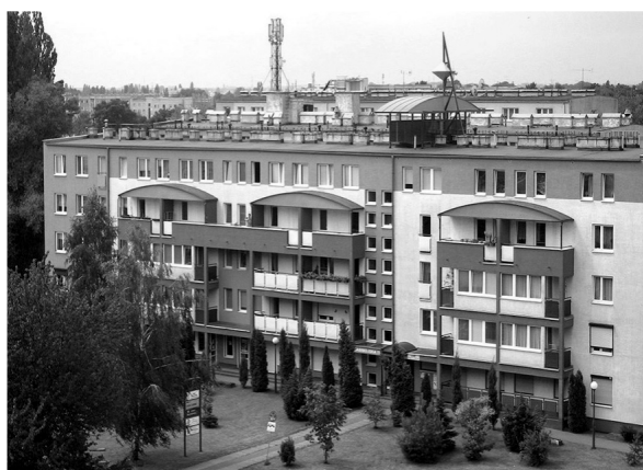
II. 3. Blok mieszkalny ocieplony i wykończony kolorowym tynkiem cienkowarstwowym (fot. J. Górski)
