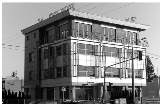
II. 6. Budynek biurowy (Raszyn). Żaluzje zewnętrzne są głównie elementem dekoracyjnym podkreślając pionowy na elewacji. Funkcja osłony przeciwsłonecznej jest niepełna. Widok od strony północno-zachodniej (fot. J. Górski)
