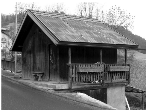
II. 5. Panele fotowoltaiczne na dachu starego budynku gospodarczego – widok niekonwencjonalny ale bardzo znamienity (fot. J. Górski)
