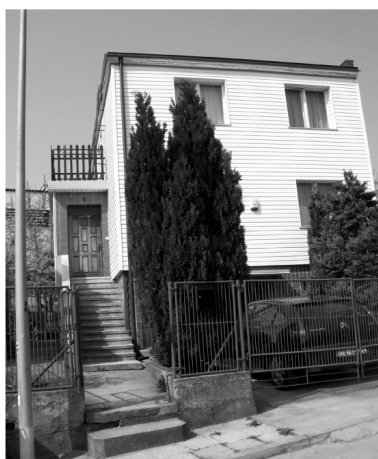
II. 2. Budynek jednorodzinny z lat 70. Wejście główne na poziomie pierwszego piętra. Na początku lat 90. elewacja unowocześniona winylowym szalowaniem (fot. J. Górski)
