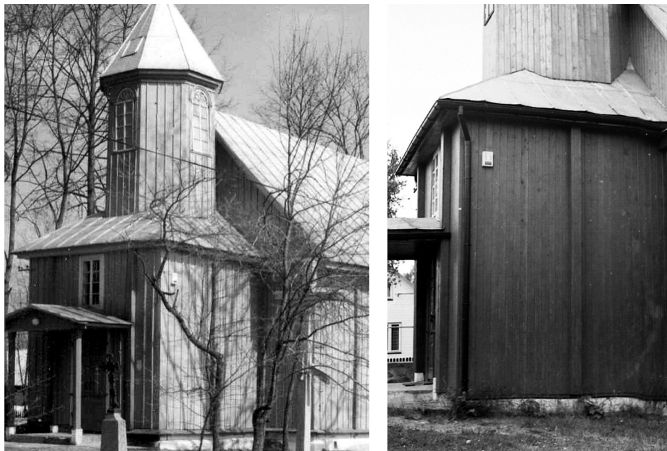
II. 3, 4. Topolany. Cerkiew. Po lewej – widok sprzed remontu (fot. A. Owerczuk, 1999), po prawej – widok po pracach remontowych (fot. A. Owerczuk, 2002)
