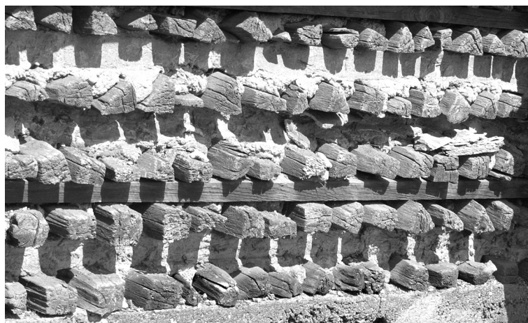
II. 1. Fragment ściany z polan we wsi Turczyn koło Białegostoku
