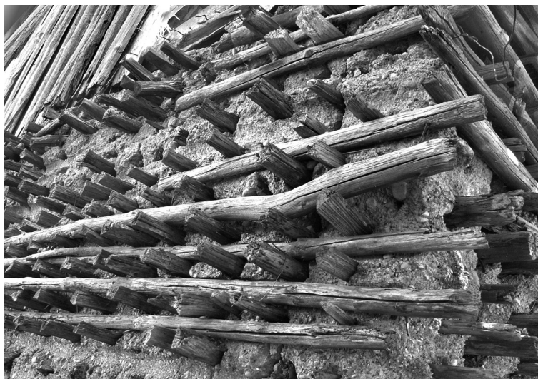
II. 3. Fragment ściany z polan we wsi Gliniszczce koło Sokółki
