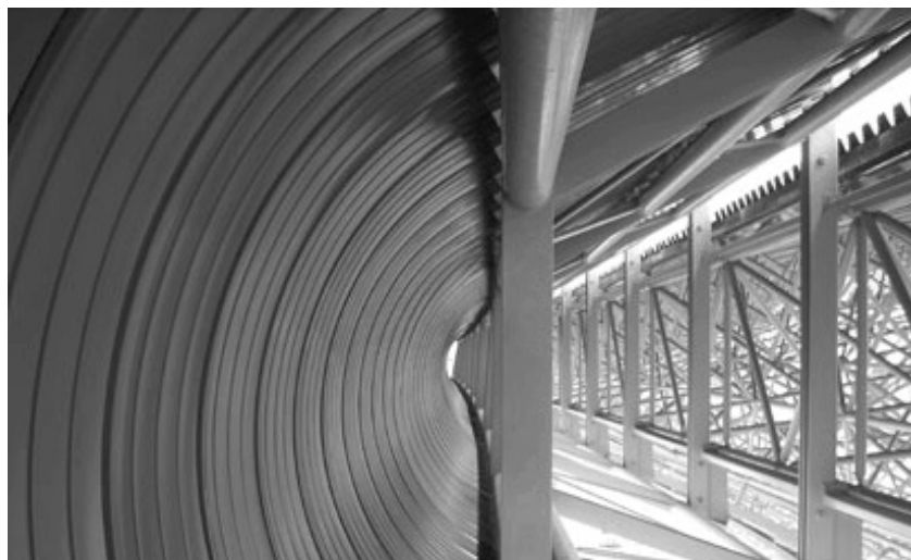
II. 4. Przykład konstrukcji stalowej obudowanej panelami o małym promieniu gięcia [7]
