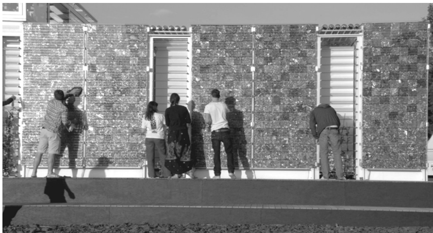
III. 3. PV cell modules (in real multi-colour) on the east and west façade (source: J. Cremers) II. 3. Moduły fotowoltaiczne (w rzeczywistości kolorowe) na wschodniej i zachodniej elewacji (źródło: J. Cremers)
