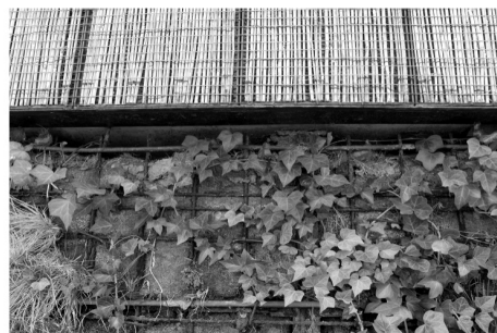
II. 14a) Madryt. Osiedle Carabanchel. Ogród osłania ściany przyziemia; widoczne kraty i filc b) Madryt. Osiedle Carabanchel. Kraty, filc, siatka i nieudane próby „doklejania” gleby (fot. W. Kosiński, 2010)
