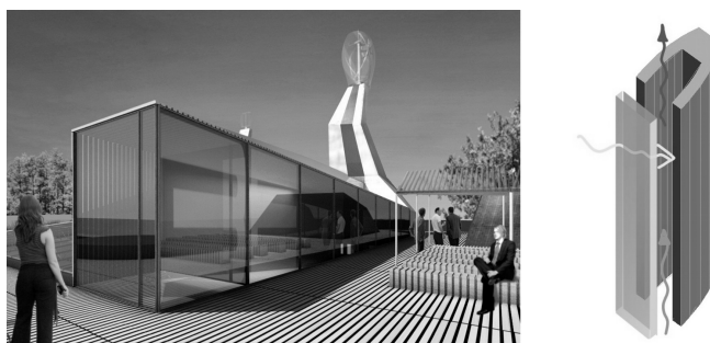
II. 11, 12. Kominy solarne – zeroenergetyczny budynek badawczo-edukacyjny 3E we Wrocławiu, projekt autorski arch. P. Kuczia (wizualizacja A. Pluta)
