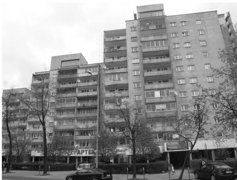
Il. 1. Budynek, w którym wykonano pomiary temperatury w dwóch loggiach
