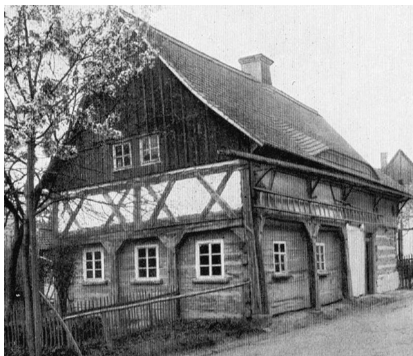
II. 1. Budynek mieszkalny z konstrukcją przysłupową
