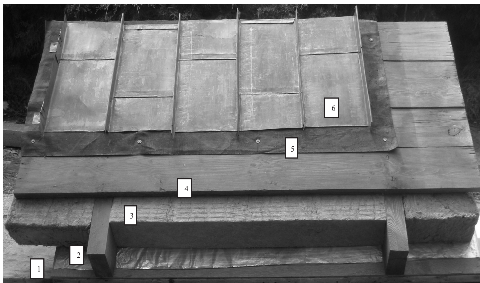
Il. 5. Układ warstw w połaci krytej blachą płaską: 1) podkład pod paraizolację, 2) paraizolacja, 3) izolacja termiczna, 4) podkład z desek, 5) folia wierzchniego krycia, 6) pokrycie z blach płaskich
