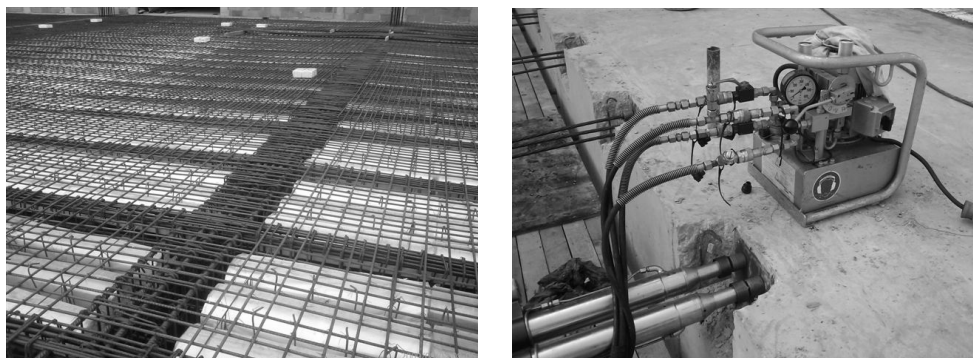
Il. 5. Realizacja stropu: a) przed zabetonowaniem, b) podczas naciągu cięgien
