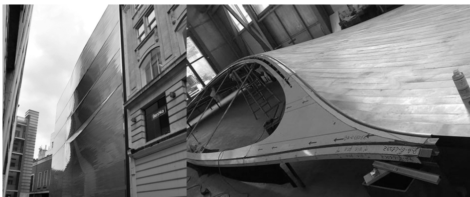
II. 2. Widok elewacji oraz testowanie rozwiązań szczegółowych
