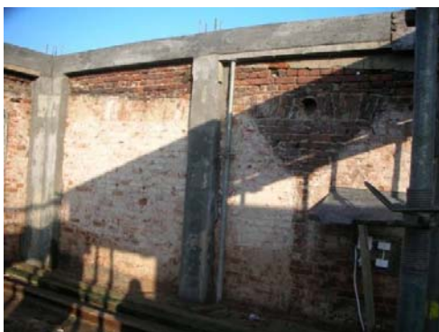
Rys. 18. Wzmocnienia starych ścian rdzeniami żelbetowymi. Fot. Arch. Studio-Projekt, 2007 r.
