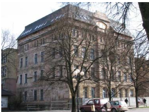
Rys. 24. Okna połaciowe w dachu kamienicy przed decyzją o ich usunięciu. Fot. Archiwum Studio-Projekt, 2007 r. Fig. 24. Windows located in building roof before decision of their removal
