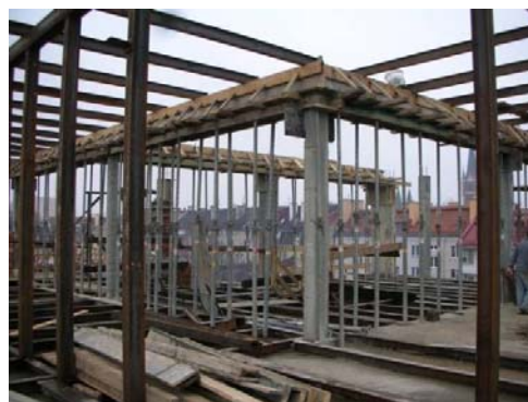
Rys. 19. Fragment konstrukcji mansardowego dachu. Fot. Archiwum Studio-Projekt, 2007 r.
