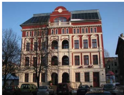
Rys. 2. Elewacja frontowa od strony ulicy Dąbrowszczaków. Fot. B. Deja, marzec 2011 r.
