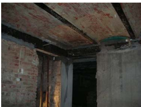
Rys. 7. Piwnice pod stropem odcinkowym przed remontem. Fot. 1 Archiwum Studio-Proj., 2007 r.
