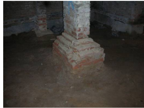
Rys. 13. Słup w piwnicy przed jej pogłębieniem. Fot. Archiwum Studio-Projekt, 2007 r.
