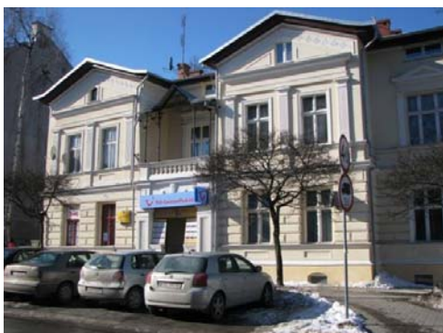
Rys. 26. Budynek po drugiej stronie ul. Dąbrowszczaków. Fot. B. Deja, luty 2011 r. Fig. 26. Building located on the other side of Dąbrowszczaków Street
