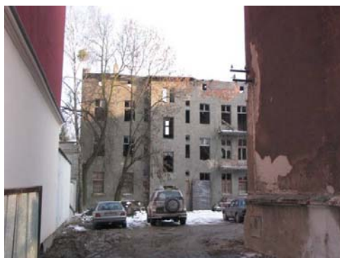
Rys. 27. Widok na sąsiednie podwórze i budynek z tyłu działki. Fot. B. Deja, luty 2011 r. Fig. 27. View to the adjacent courtyard and to the building located at the back of building plot
