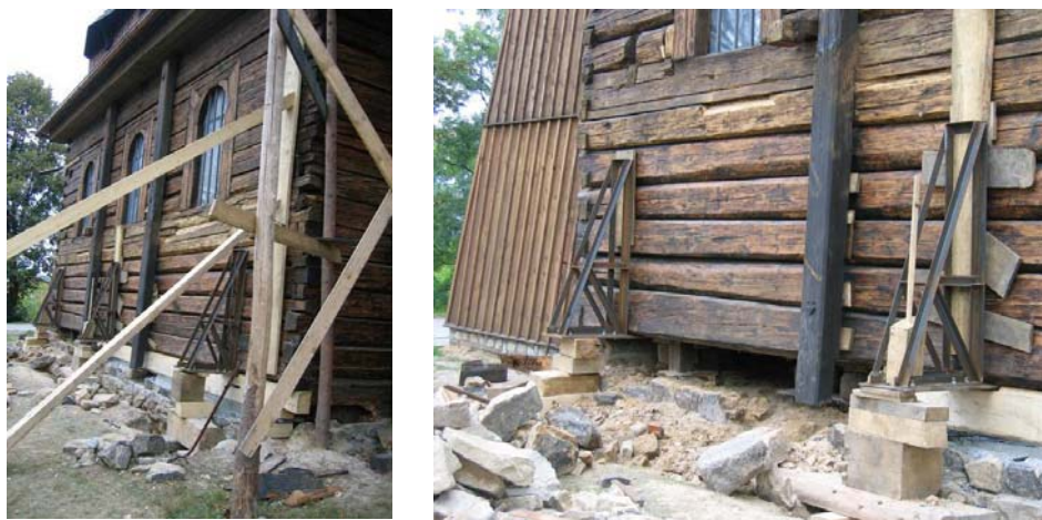
Rys. 6. Wymiana belki podwalinowej - kościół w Żernicy
