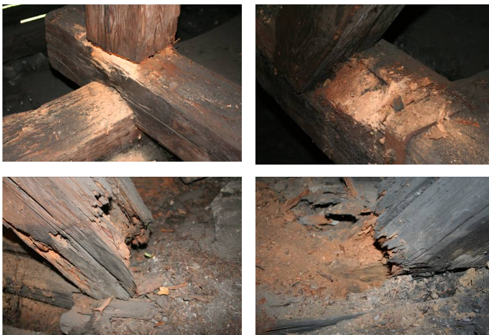
Rys. 1. Obrazy biologicznych zniszczeń w miejscach oparcie krokwi, stopnic i słupków na namurnicach i belkach w kościele p.w. Św. Bartłomieja w Gliwicach z XVI wieku
