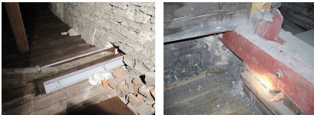
Rys. 13. Wzmocnienia stref oparcia zbutwiałych belek nośnych elementami stalowymi w kościele p.w. Podwyższenia Krzyża Świętego w Sławkowie (XIII w.)
