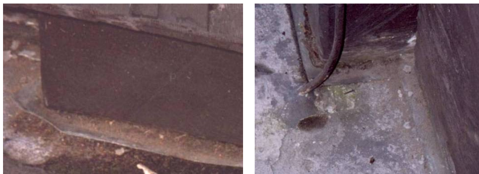
Rys. 9. Stan poziomej izolacji z blachy miedzianej po 15 latach eksploatacji – kościół p.w. Św. Michała Archaniola w Katowicach (XVI w.)
