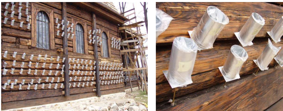
Rys. 18. Widok i szczegół ścian kościoła p.w. Św. Michała Archaniola w Żernicy podczas impregnacji grawitacyjnej
