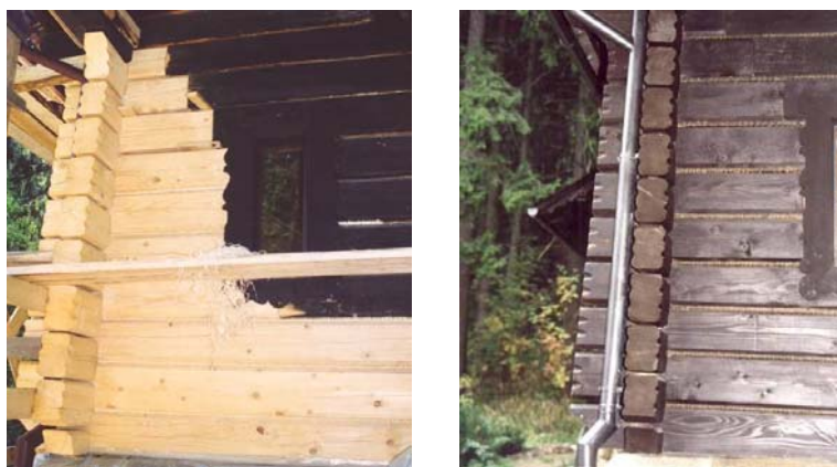
Rys. 10. Wymiana uszkodzonych bali ścian kaplica p.w. Św. Jadwigi Śląskiej w Wiśle Czarnym Fig. 10. Exchange of damaged walls beams of chapel Of St Silesian Jadwiga in the Wisła-Czarne
