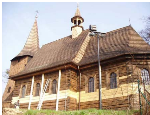
Rys. 11. Wymiana elementów ścian i lisic w kościele p.w. Św. Michała Archanioła w Żernicy Fig. 11. Exchange of elements of walls and vixens at the of church of St Archangel Michał in Żernica
