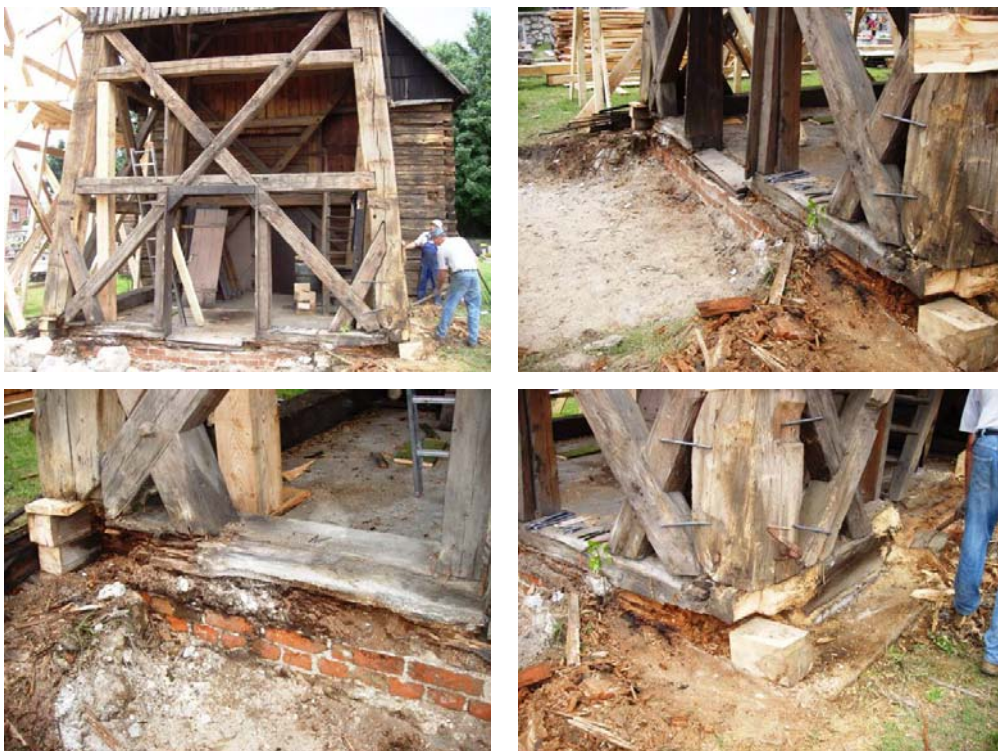
Rys. 8. Wymiana podwalin wieży kościoła w Smolnicy
