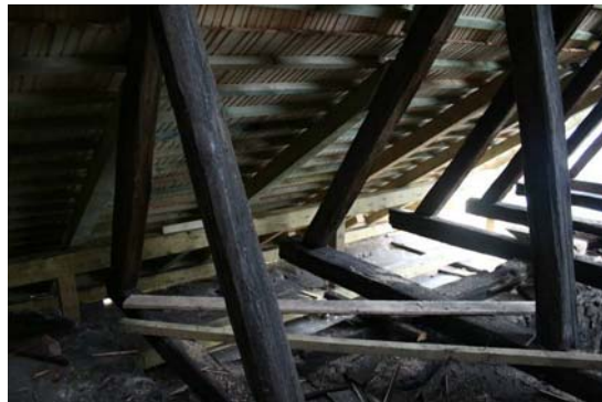
Rys. 3. Namurnice i przypustnice oraz pokrycie dachu w trakcie remontu w kościele p.w. Św. Bartłomieja w Gliwicach
