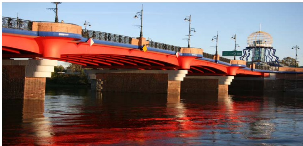
Rys. 2. Widok mostu Staromiejskiego przez Wartę w Gorzowie Wielkopolskim po rewitalizacji w latach 2006–2007 [4]
