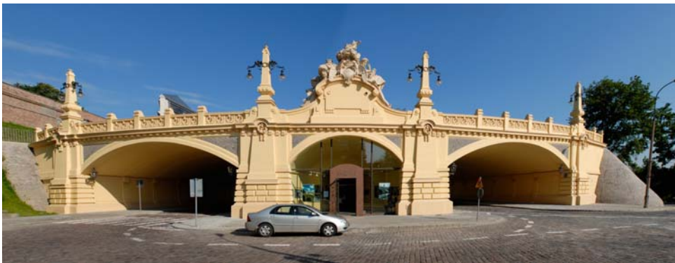
Rys. 4. Widok ogólny wiaduktu w 2007 r. [7]
