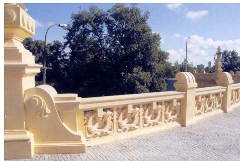
Rys. 7. Betonowa balustrada po rekonstrukcji [6]
