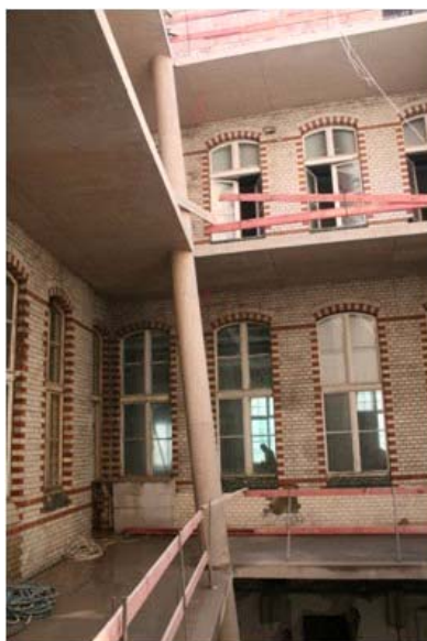
Rys. 21. Zastosowanie słupów pochyłych w modernizacji budynku zabytkowego – słupy podtrzymujące pomosty komunikacyjne w wielokondygnacyjnym budynku murowanym
