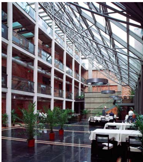
Rys. 22. Zastosowanie betonu monolitycznego do rozwiązań konstrukcyjnych w zabytkowym budynku murowanym, w którym występuje również szkło oraz stal
