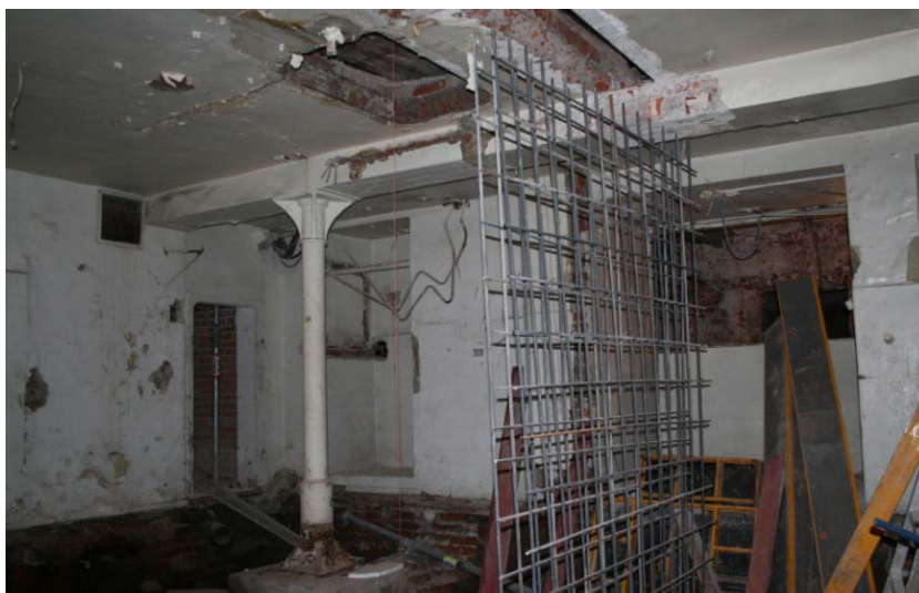
Rys. 23. Zbrojenie nowej ściany z betonu w piwnicy modernizowanego budynku zabytkowego Fig. 23. Reinforcement for new wall made of concrete in basement of modernized building
