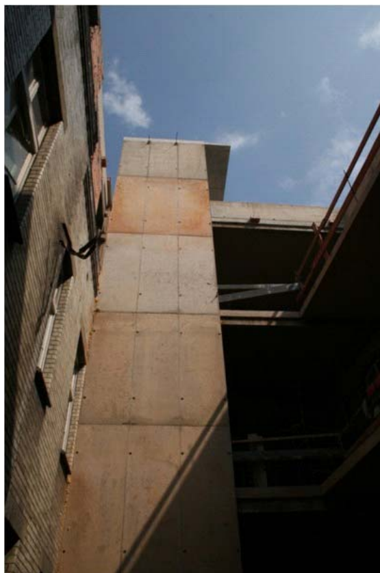
Rys. 20. Ściana żelbetowa usztywniająca zabytkową konstrukcję ścienną, która jednocześnie pełni funkcję nośną dla szybu windowego
