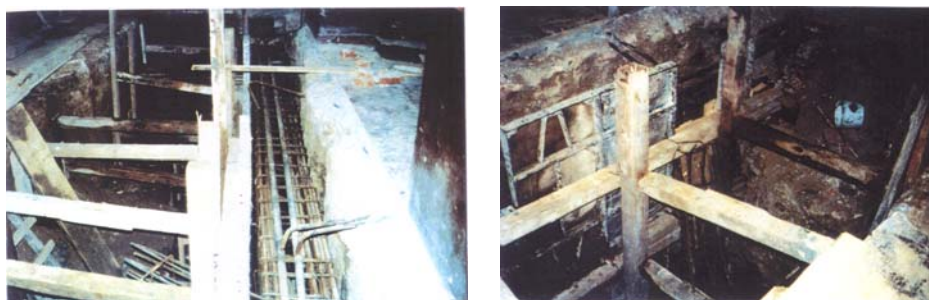
Rys. 8. Zbrojenie fundamentowej tarczy wewnętrznej przy północnej ścianie kościoła
