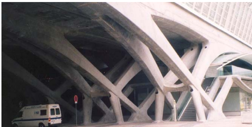
Rys. 17. Konstrukcja z betonu monolitycznego dworca w Lizbonie – projektant S. Calatrava
