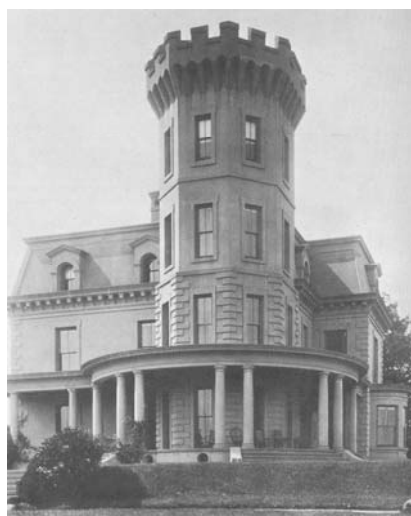
Rys. 2. Jeden z pierwszych budynków W.E. Words'a całkowicie wykonanych z betonu (Portchester koło Nowego Jorku – 1873–1876 r.) [1]
