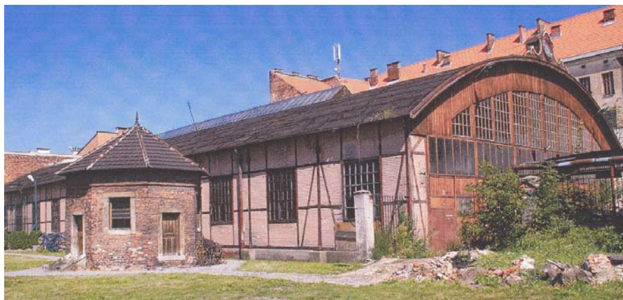
Rys. 3. Widok hali od strony południowo-zachodniej przed rekonstrukcją
