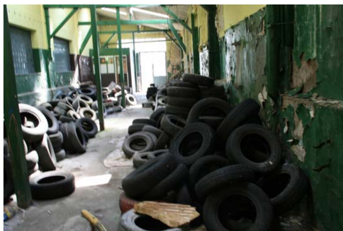
Rys. 14. Fragment małej hali przed remontem i rekonstrukcją
