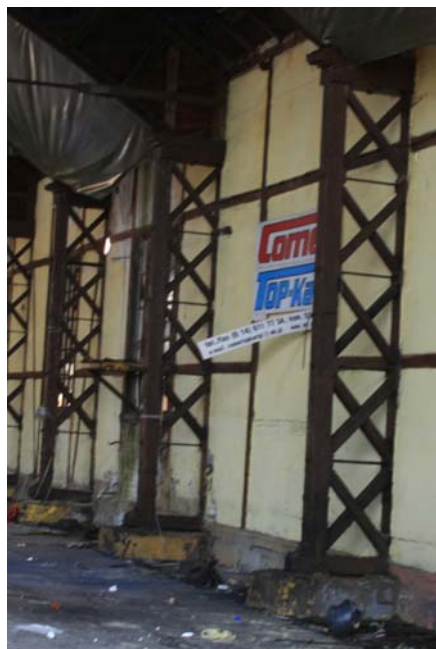
Rys. 10. Widok słupów dwugłęziowych w hali głównej
