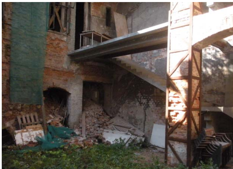
Rys. 8. Kraków, ul. Gołębia 6. Stan galerii komunikacyjnej i oficyny po przerwaniu prac zabezpieczających w 2005 r.
