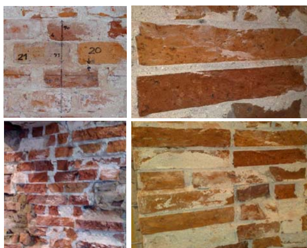
Rys. 6. Widok układu cegieł na licu muru i w jego przekroju po wyburzeniu
