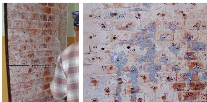
Rys. 7. Wiercenie otworów w murze oraz ich rozmieszczenie na licu ściany
