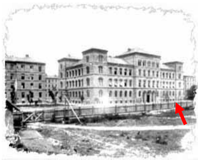
Rys. 4. Widok budynku WIL PK przy ul. Warszawskiej 24 w Krakowie z okresu budowy w latach 70. XIX w.,
