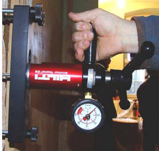
Rys. 8. Wrywanie kotwy stalowej z muru (test pull-out) przy użyciu testera HAT28 Fig. 8. Pull-out testing of the steel anchor from the masonry using of the HAT28 tester
