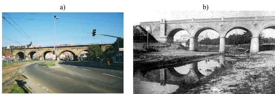
Rys. 7. a) widok ogólny wiaduktu kolejowego nad ul. Grzegorzewką od strony zach.(stan z 2011), b) widok ogólny mostu kolejowego nad Starą Wisłą od strony zachodniej Fot. Walentego Rzewuskiego (1870-80) ze zbiorów Archiwum Państwowego w Krakowie
