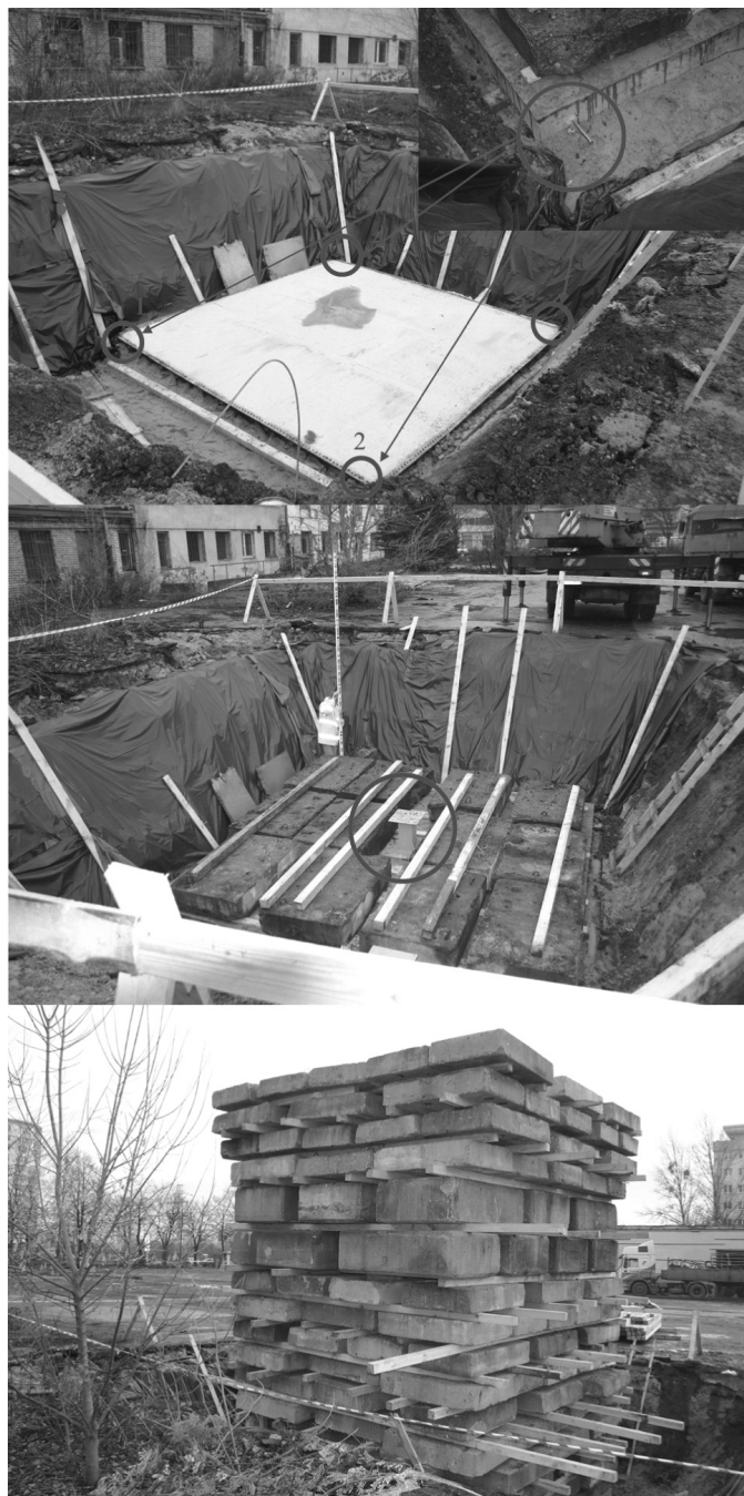
Rys. 2. Wielkowymiarowe próby obciążeniowe
