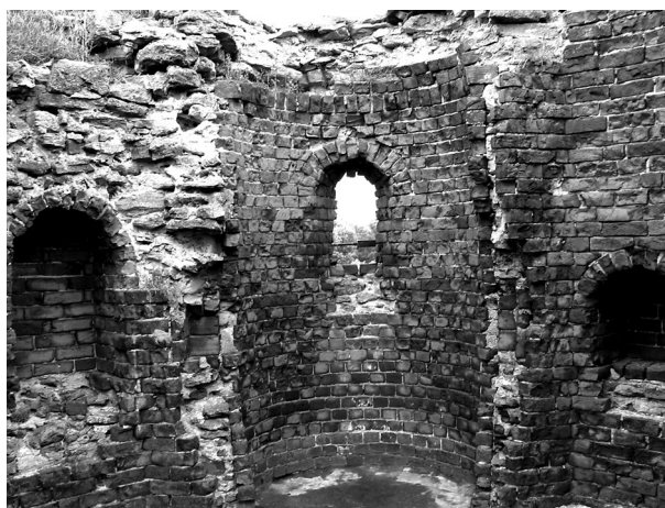
Il. 11. Apsyda wschodnia na ostatniej kondygnacji wieży z obudową ceglana i przyległymi do niej niszami liturgicznymi. Fot. M. Auch
