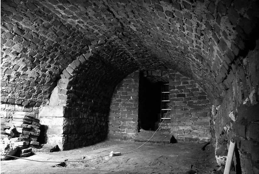
II. 9. Kraków, Bazylika Mariacka, krypta nr 5. Wnętrze od południa, w głębi narożnik NW z ciosami piaskowca. Fot. J. Firlet
