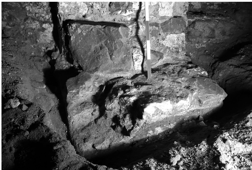
II. 7. Kraków, Bazylika Mariacka, krypta nr 40. Filar powiązany z kamienną ścianą, widoczny wtórnie wykorzystany materiał romański. Fot. J. Firlet III. 7. Krakow, Basilica of St. Mary's, crypt no. 40. A pillar connected with a stone wall, visible re-used Romanesque material. Photo by J. Firlet
