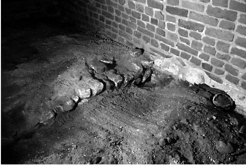
Il. 4. Kraków, Bazylika Mariacka, krypty nr 31 i 32. Relikt muru północnego z użyciem kostki w licu, po prawej podmurówka z łamanego wapienia. Fot. J. Firlet
