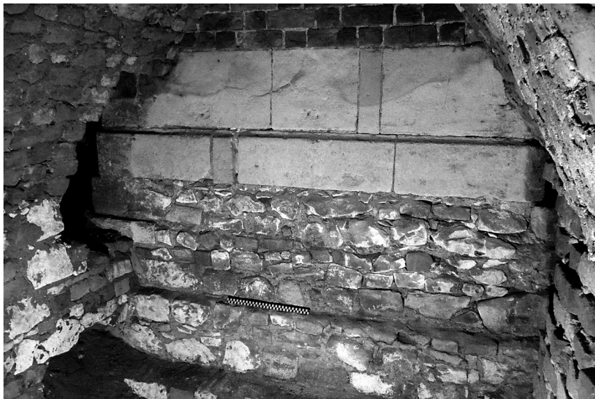
II. 12. Kraków, Bazylika Mariacka, krypta nr 37a. Ściana S wnętrza wieży, widoczny wtórny materiał romański w fundamencie, powyżej cokół. Fot. J. Firlet III. 12. Krakow, Basilica of St. Mary's, crypt no. 37a. The southern wall of the tower interior, visible secondary Romanesque material in the foundations, above – a plinth. Photo by J. Firlet
