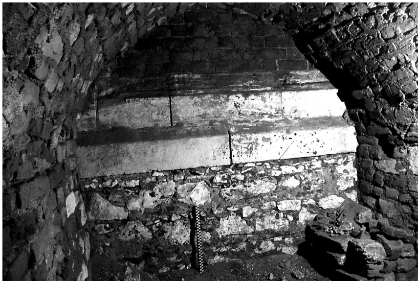
II. 13. Kraków, Bazylika Mariacka, krypta nr 37a. Ściana N wnętrza wieży, powyżej fundamentu cokół i lico ceglane o wątku polskim. Fot. J. Firlet III. 13. Krakow, Basilica of St. Mary's, crypt no. 37a. The northern wall of the tower interior, above the foundations, a plinth and a brick face with Polish pattern. Photo by J. Firlet
