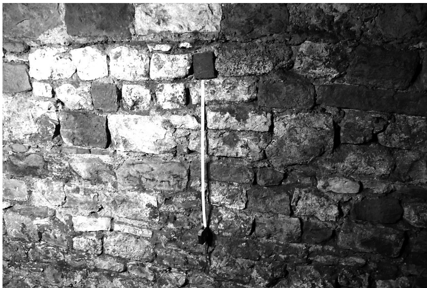
Il. 11. Kraków, Bazylika Mariacka, krypta nr 5. Ściana S z materiałem romańskim, pośrodku główka cegły. Fot. J. Firlet
