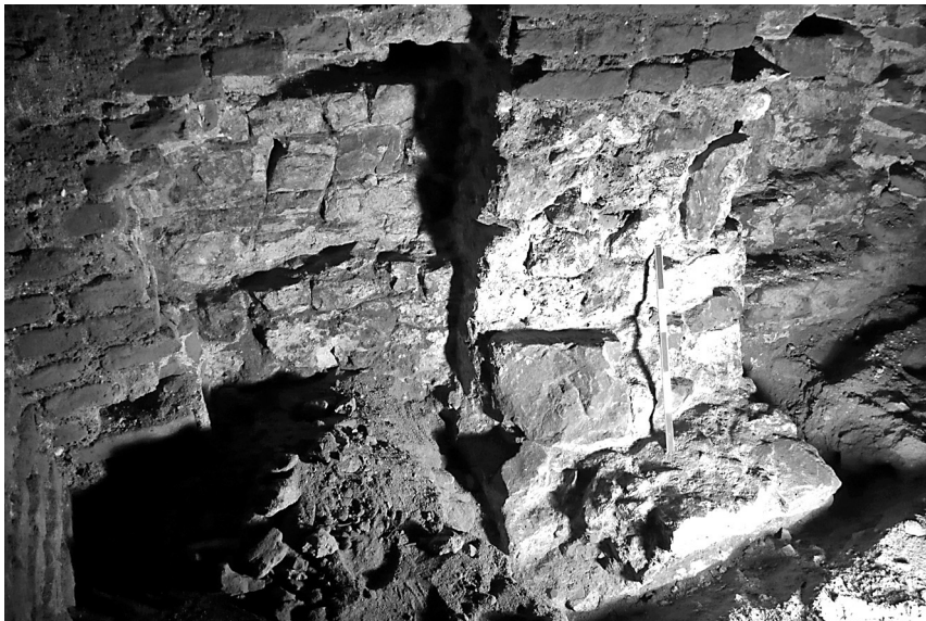
II. 8. Kraków, Bazylika Mariacka, krypta nr 40. Dolna część filara, we wnętrzu muru widoczny cios piaskowcowy oraz fragmenty cegieł. Fot. J. Firlet III. 8. Krakow, Basilica of St. Mary's, crypt no. 40. The lower part of a pillar, inside the wall, sandstone ashlar and fragments of bricks are visible. Photo by J. Firlet
