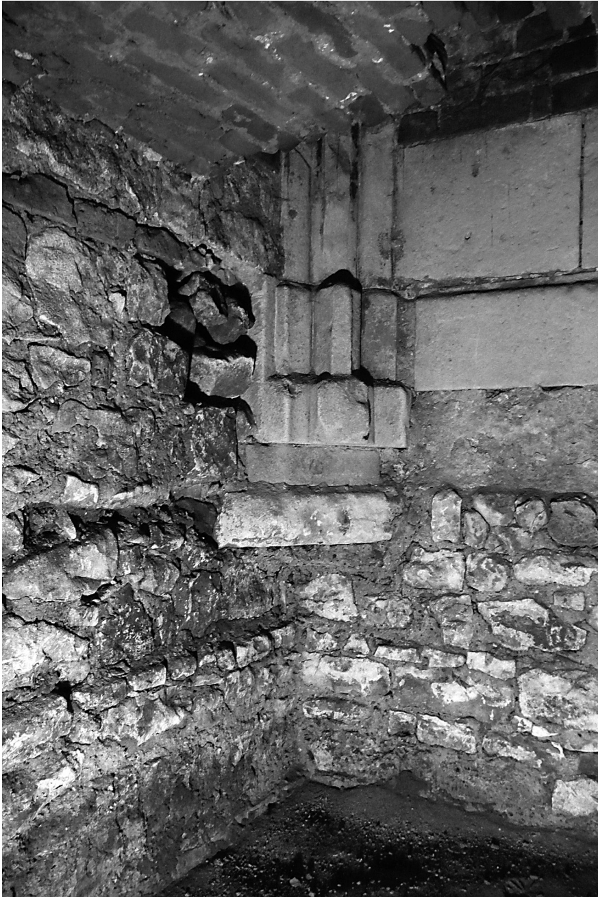
II. 14. Kraków, Bazylika Mariacka, krypta nr 37b. Ściana E wieży z cokołem i nasadą żeber narożnych, po lewej fundament S ściany kościoła. Fot. J. Firlet
