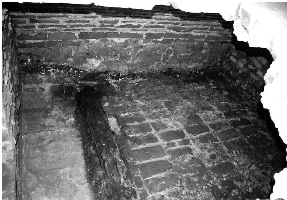
Il. 7. Katedra w Łomży, widok na posadzkę ceglana komory grobowej i legary pod trumnę Ill. 7. The Cathedral in Łomża, view on a brick floor of the burial chamber and the beams for the coffin
