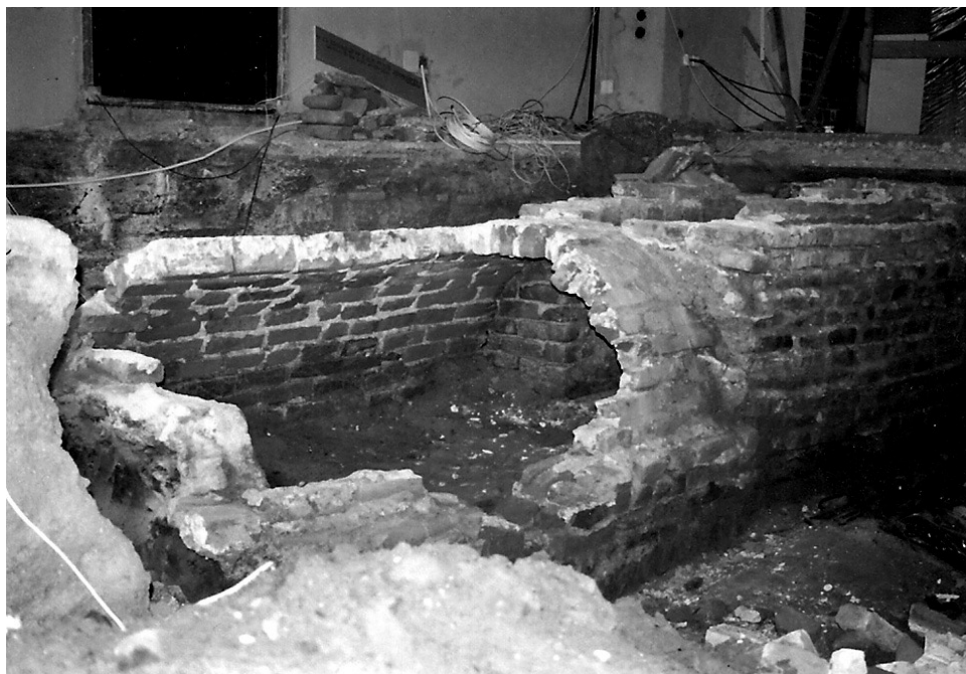
Il. 2. Katedra w Łomży, widok na elementy konstrukcyjne krypty Ill. 2. The Cathedral in Łomża, view on construction elements of the crypt
