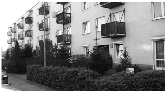
II. 3. Zieleń oddzielająca chodnik od okien budynku. Szczecin
