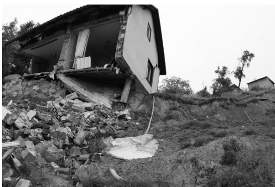
I. 1. Osuwisko w Lanckoronnie
