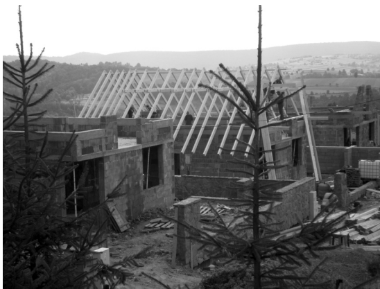
II. 2. Budowa osiedla „Słoneczne Tarasy”
