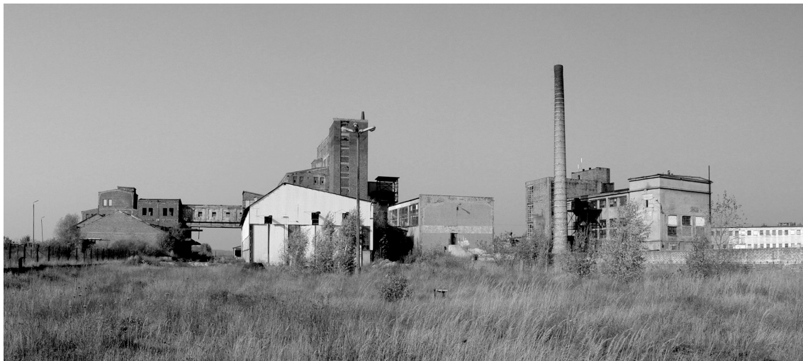
II. 4. Niezagospodarowane nadszybie nieistniejącej kopalni soli w Wapnie – zespół obiektów opuszczony po katastrofie górniczej, do której doszło w 1977 roku (fot. P. Langer)
